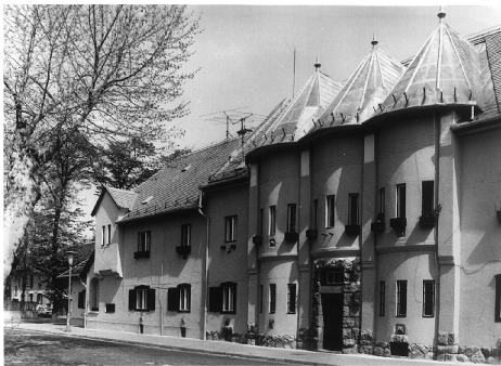
17. ábra Munkástelepi lakások
