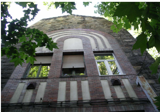
7. Igazgatósági épület homlokzat
